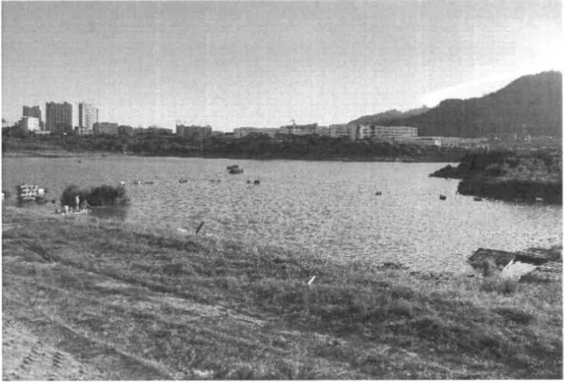
林口水库库区照片图
